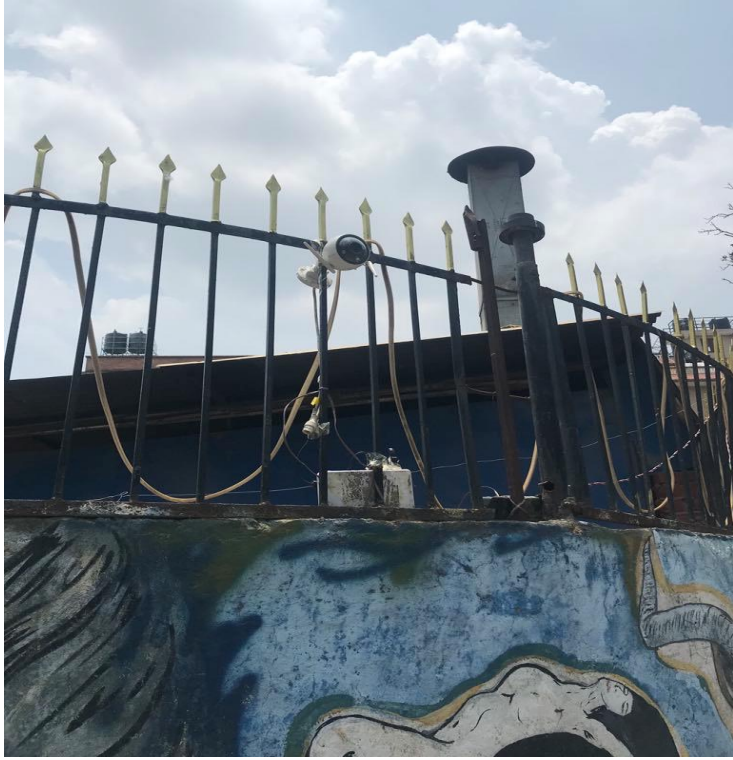
CCTV positioning at C7J11: UN Park Jn.
